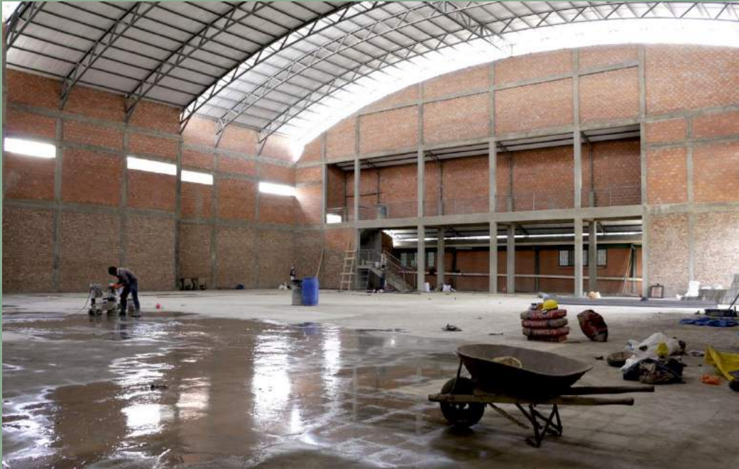
Ampliación Almacén de Medicamentos
